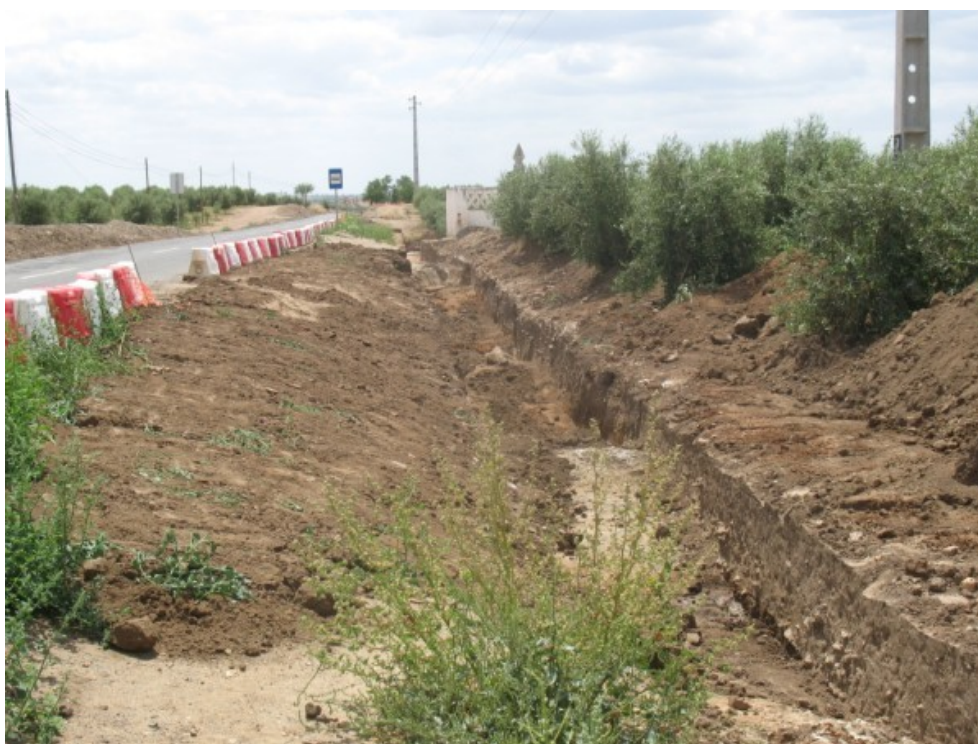
Fotografia 11: Aspecto geral após a finalização dos trabalhos
